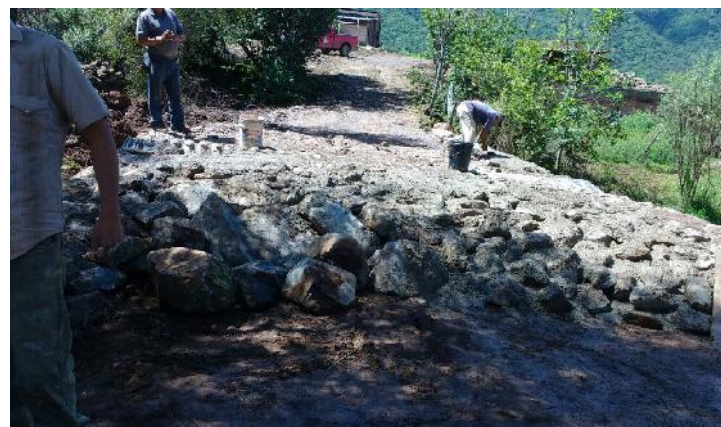
REHABILITACIÓN DE VADO EN GALLINEROS.
