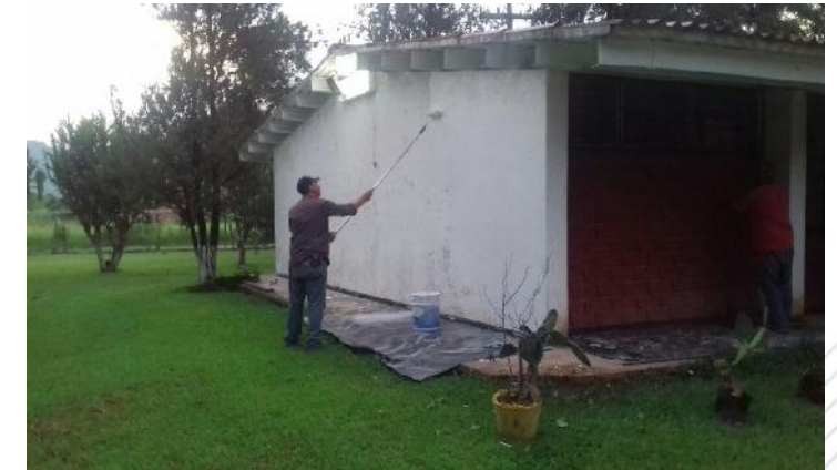
PINTURA EN LAS INSTALACIONES DEL C.B.T.A #31.
