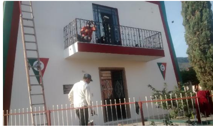
REHABILITACIÓN DE COMEDOR COMUNITARIO.
