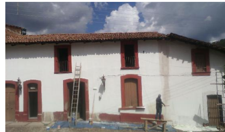
REHABILITACIÓN DE FACHADAS.
