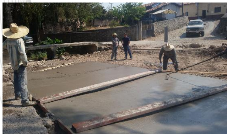
REHABILITACIÓN DE VADO EN CIMARRÓN CHICO.
