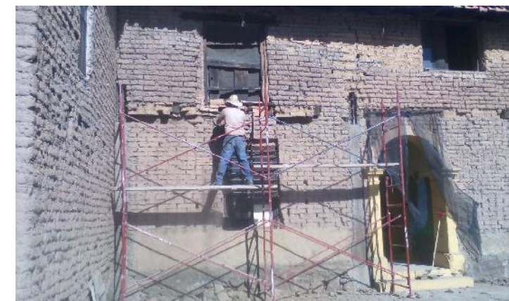
REHABILITACIÓN DE DELEGACIÓN EN NAVIDAD
